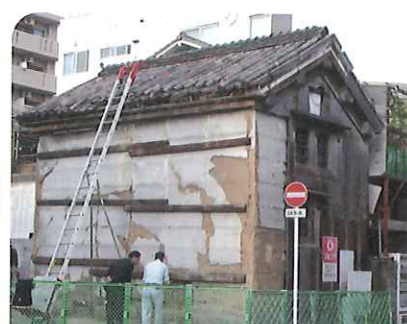
2010.8.31 解体前の蔵(東区愛宕町)
