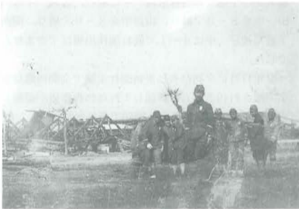
昭和21年2月13日 修道中学校崩壊した校舎
