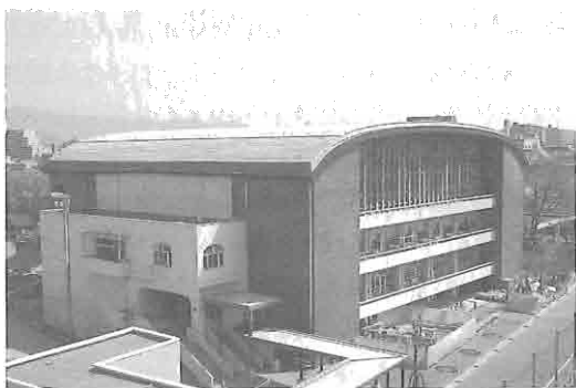
解体前の体育館
