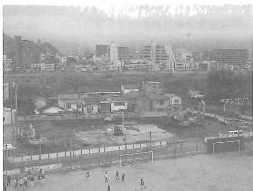
解体工事終了後
